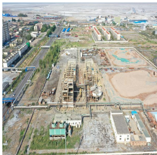
厂区东向视图
