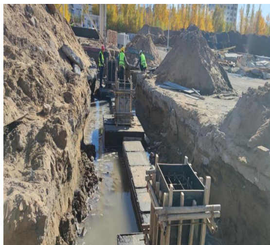
干燥仓储车间基础开挖
