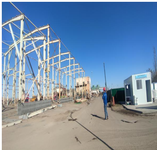
厂内原有道路（南侧） 及项目施工道路
