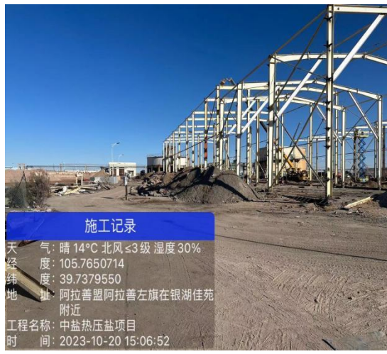
厂内原有道路（北侧） 及项目施工道路
