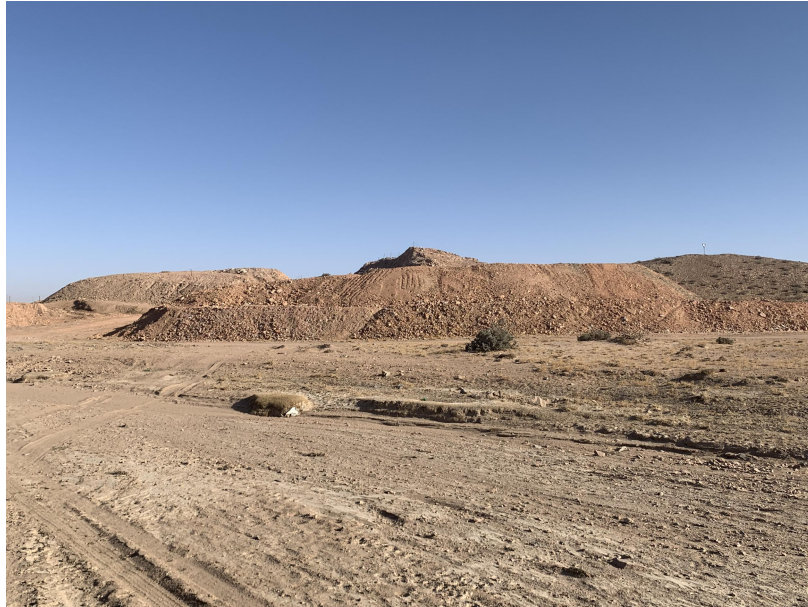
照片 2-5 排土场治理现状
