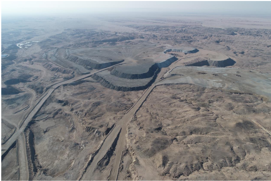
排土场现状照片
