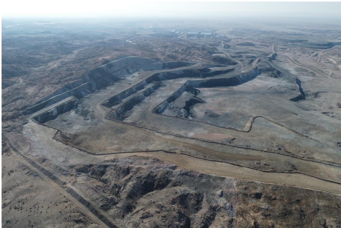
采区现状照片
